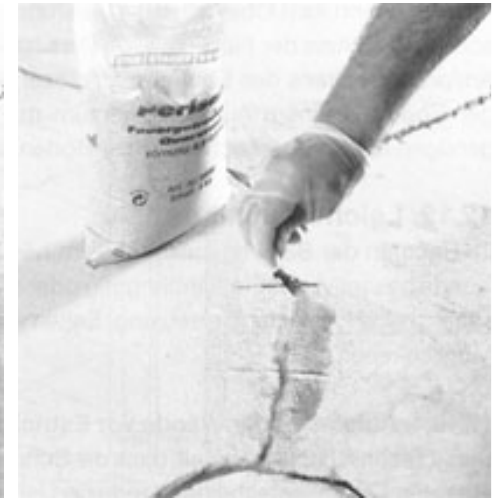
Επίταση χαλαζιακής άμμου και χρώματος σε σκόνη για την επίτευξη ίδιου χρώματος
