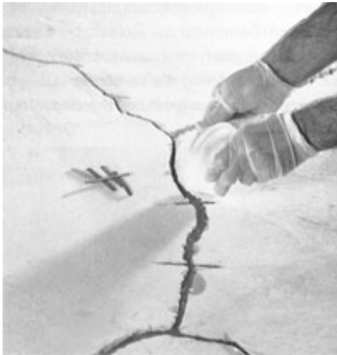
Τοποθέτηση ραμμάτων στις εγκάρσιες τομές
