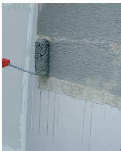
Η εφαρμογή με ρολό χρειάζεται 3 "χέρια" για να έχουμε τελικό στεγνό στρώμα πάχους 2 mm
