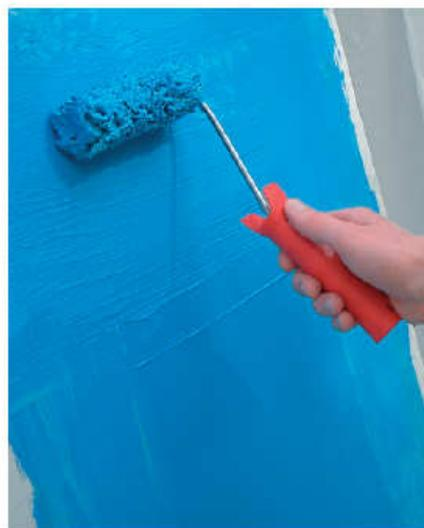
Εάν χρησιμοποιήσετε ρολό εφαρμόστε 2η φορά κάθετα στην πρώτη για να βεβαιωθείτε ότι έγινε σωστή εφαρμογή
