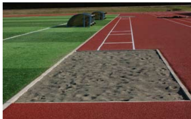
Sprunggruben- und Laufbahneinfassung mit Weichkantenstein
