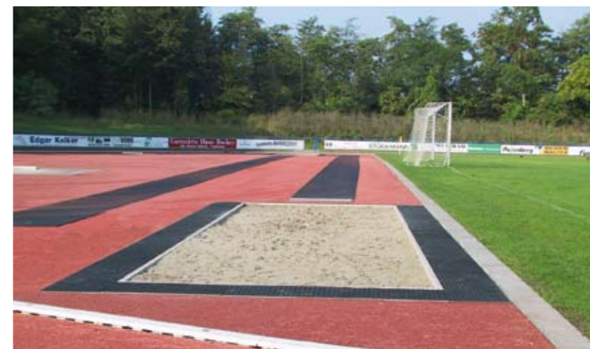
Randeinfassung einer Weitsprunganlage
